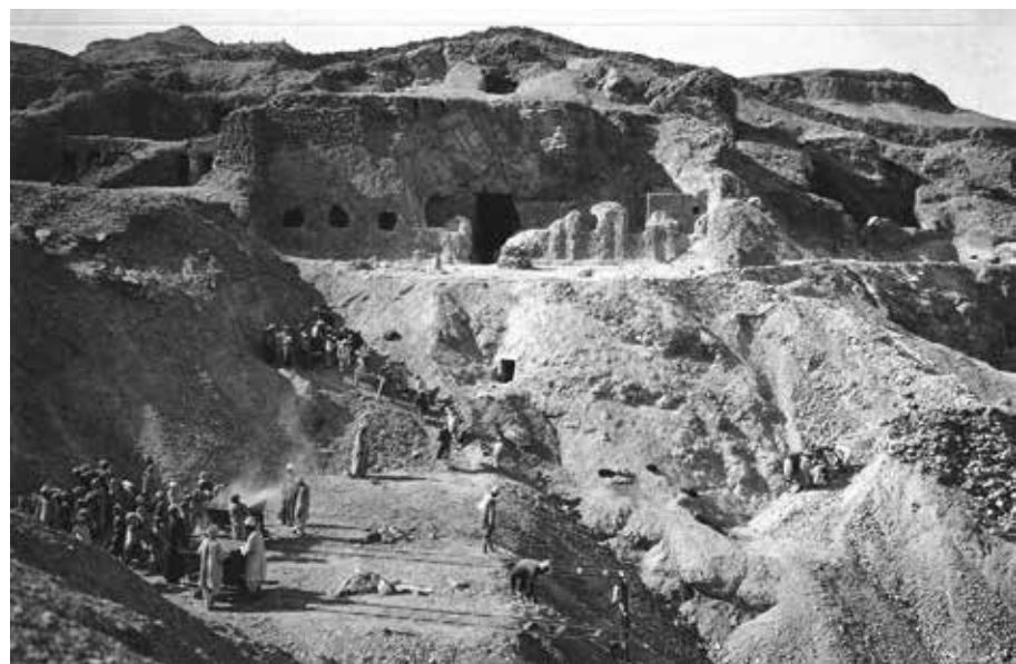
Fig. 7 TT71 under udgravningen af den opbyggede terrasse i 1935-36. Midt på skråningen ses åbningen til graven tilhørende Senenmuts forældre, Ramose og Hatnofer. Fra Dorman (1991), pl. 1a.
