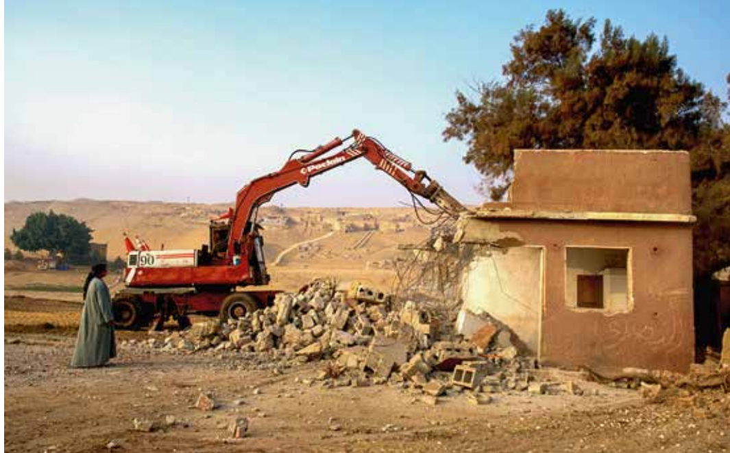
Fig. 13 Hydraulisk hammer ( daqaq på arabisk) banker badehuset ved det nordvestlige hjørne af Abu Hol Sportsklubben ned. Blik mod vest. Foto Mark Lehner.
