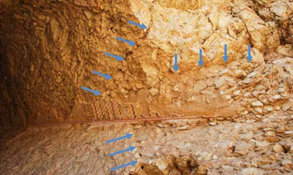
Fig. 11 Reparationsarbejde langs en geologisk brudlinje i væg og loft i begyndelsen af den centrale hal af TT71. Arbejdet med grov mørtel og mindre stykker kalksten blev sandsynligvis udført af specialisten Sennefer. Foto Heidi Kontkanen, 2011.
