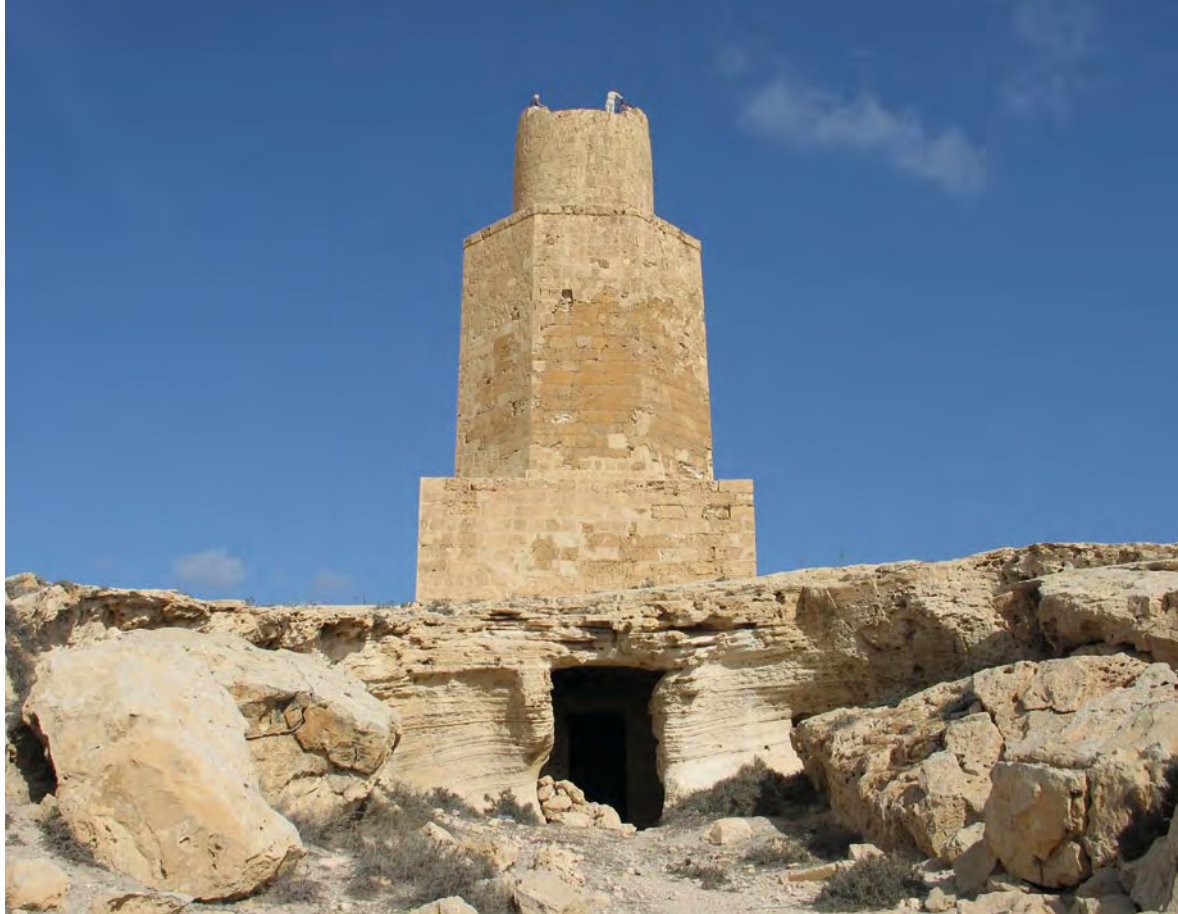
Fig. 8 Tårnet med gravkapeller under, set fra syd. Foto LM.
