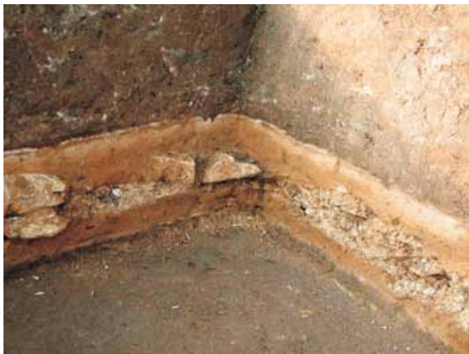
Fig. 8 Gulv “a” i forgården i snit: kalk- og sandlaget ses tydeligt ved overkanten. Størrelsen af fragmenterne i kalkstenslaget går fra de mindste splinter til blokke på flere decimeter (foto E. Pusch).
