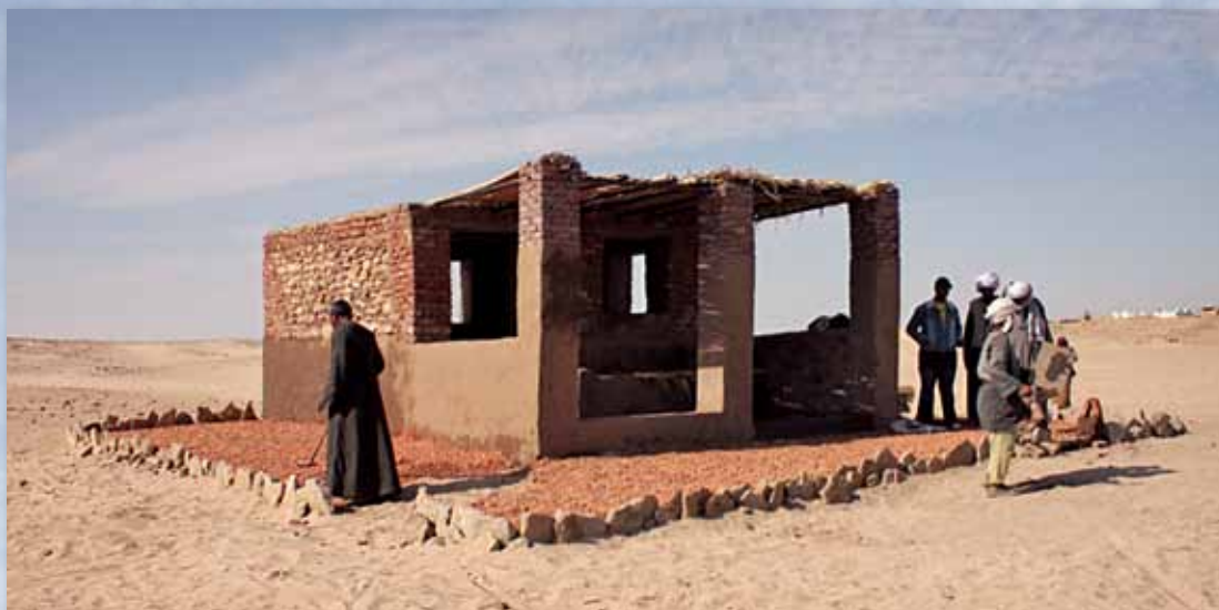
Fig. 15 Nyt hus til vagterne, bygget i 2011.
