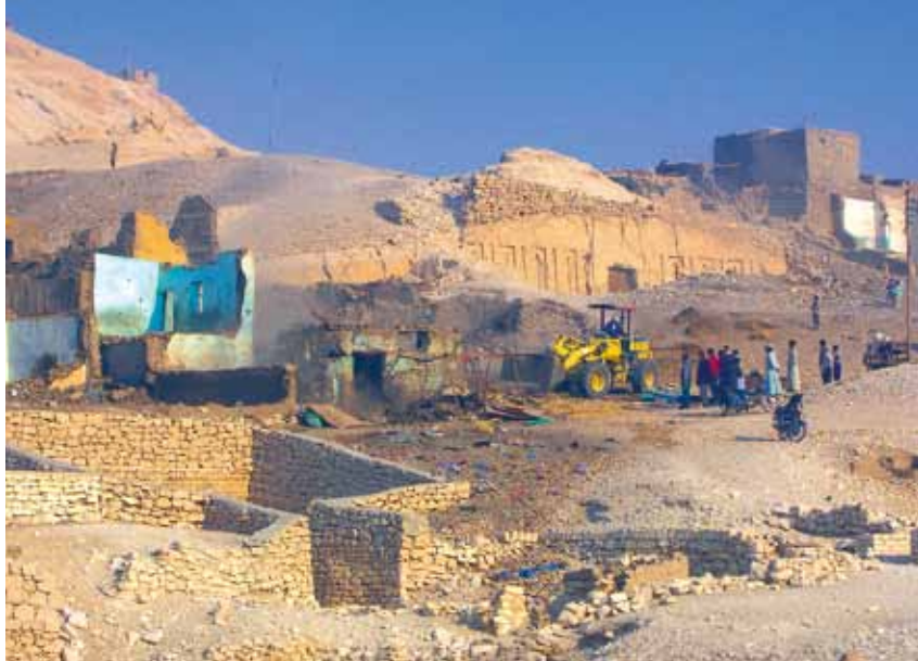
Fig. 3 Bulldozer i Gurna januar 2007 (foto Jane Akshar).
